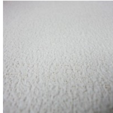
Acercamiento del vinilo perforado
